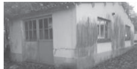
Salle attenante au bâtiment de « l'immaculée »
